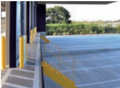
安全に配慮した階段
